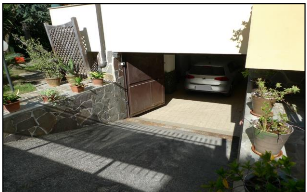
Rampa di accesso al garage
